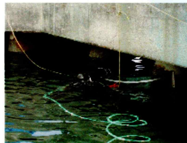
b ポリカーボネート型枠設置
